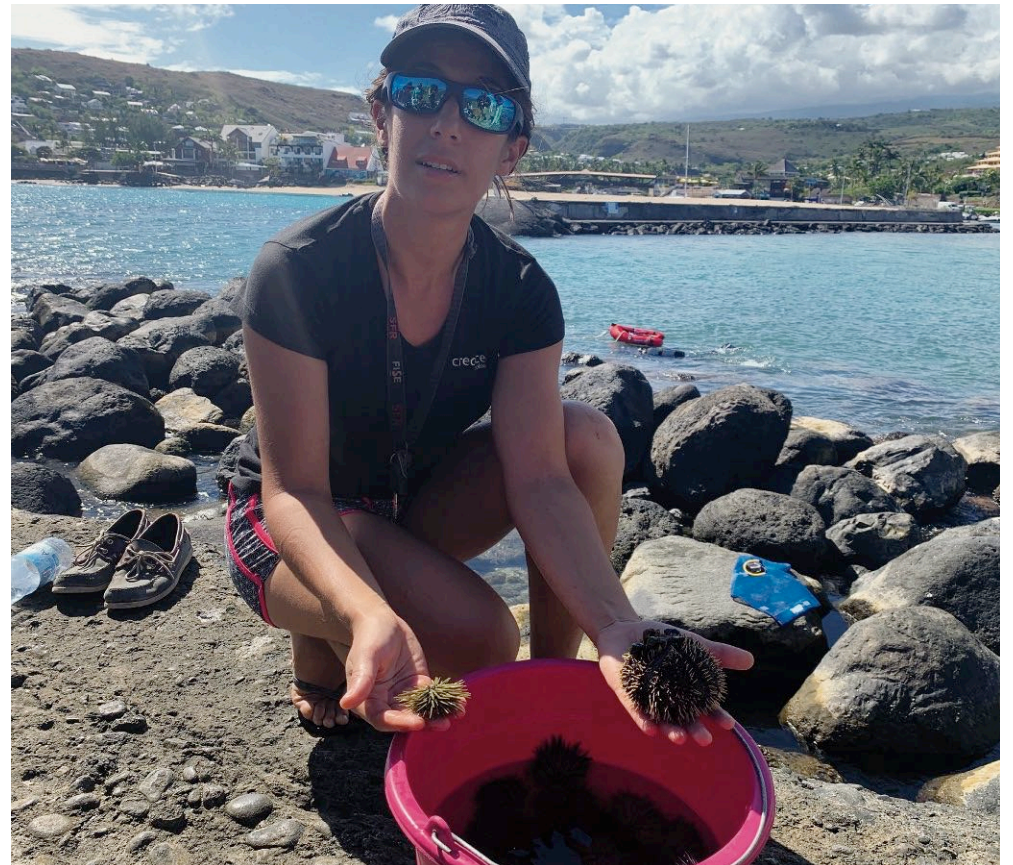
Des centaines d'oursins sont actuellement retirés et déplacés de quelques dizaines de mètres dans le cadre de la réhabilitation de la digue.
